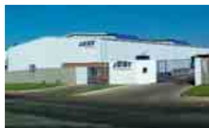
Renovierung abgeschlossen: JOST South Africa
