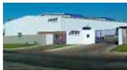
Rénovation terminée : JOST South Africa
